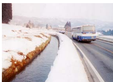
流雪溝用水の導水路（町原）
