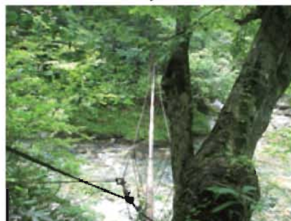
カクナラ吊り橋
